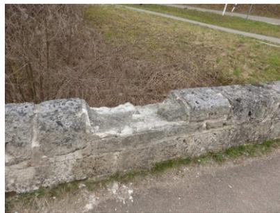
Die beobachteten Schäden am Gewölbe sind größtenteils auf die vollständige fehlende Fahrbahnabdichtung und die aus dem Jahr 1938 konstruktiv unzureichende und stark schadhafte Gewölbeabdichtung zurückzuführen.
