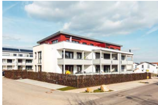
2014: Clara-Schumann-Straße 2, 4 und 6 in Heiningen, 5-, 8- und 10-Familienwohnhaus, Effizienzhaus 70
