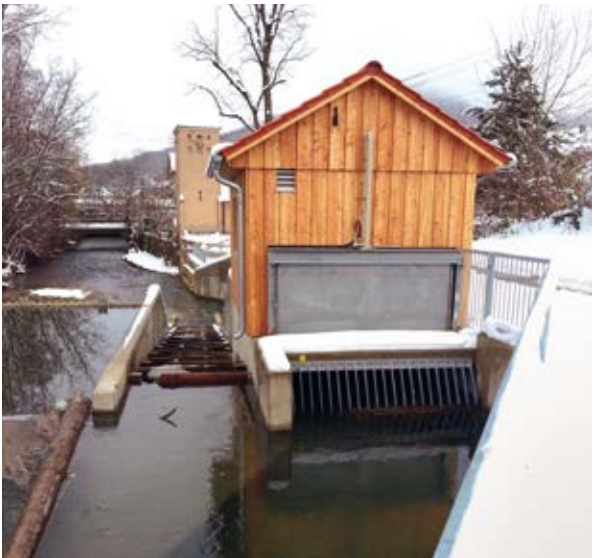
Neubau WKA Deggingen mit Fischaufstieg
