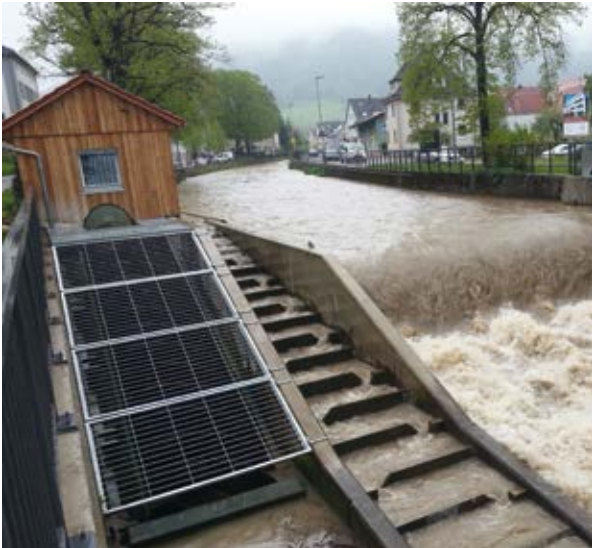
Neubau WKA Deggingen mit Fischaufstieg
