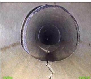
Eine detaillierte Untersuchung der hangseitigen Straßenentwässerung zeigte, dass die Längsleitungen stark geschädigt sind. Austretendes Wasser weicht den Untergrund auf und führt letztendlich zum Abrutschen der Fahrbahn.
