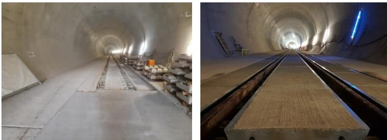
Bilder: Gleisbau und Einbau der Befahrbarkeitsplatten
